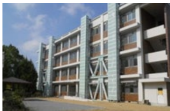
老朽改善された施設
