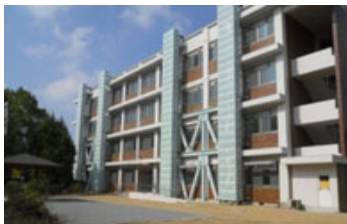
老朽改善された施設
