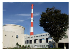
高速実験炉「常陽」
