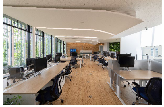
事務室の天井面を湾曲させ、自然換気(重力換気)の効果を高め、チムニーへと誘導
