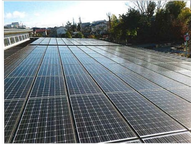
太陽光発電 設計値を大きく上回った太陽光発電量が『ZEB』の実現に大きく貢献した。一次エネルギー消費原単位2020年度実績値で636MJ/m 2 /年となっている。
