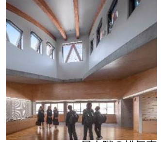
最上階の排気窓
