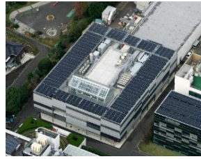
太陽光発電設備
