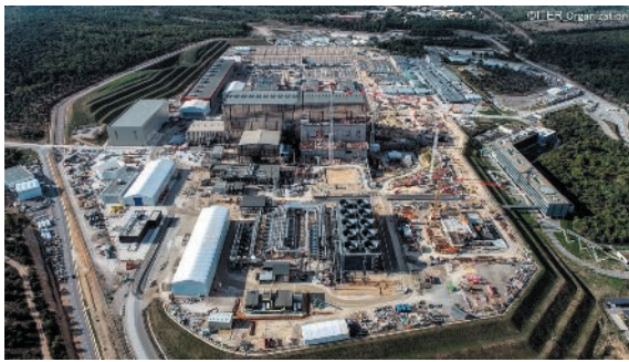
ITER (国際熱核融合実験炉) の建設状況 (2021年10月) (仏サン=ポール=レ=デュランヌ市カダラッシュ) ©ITER Organization
