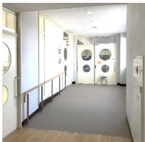
理科室入口に設置された手すりとは既設スロープ
