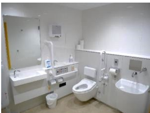
整備されたバリアフリートイレ
