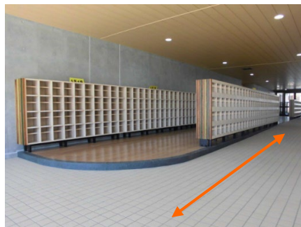
昇降口(オレンジの矢印部分がスロープ)
