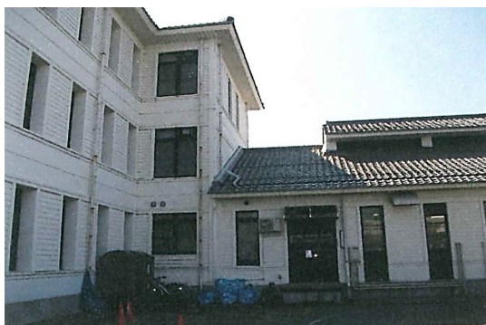
エレベーター棟設置前の外観
