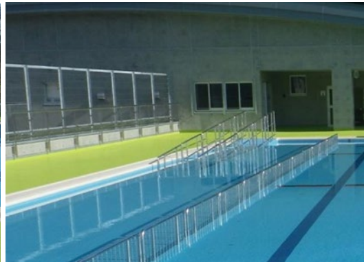
プールのスロープ部分
