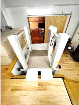
屋内運動場ステージ脇に設置された段差解消機
