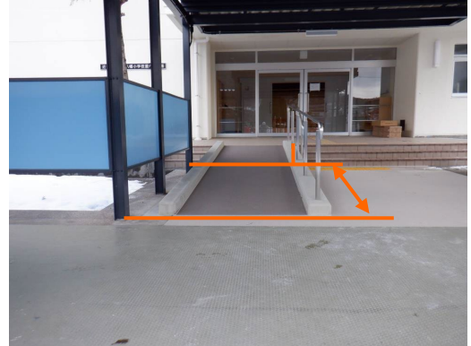
改修後の個賠が緩やかなスロープ (登り口の位置が手前の柱)
