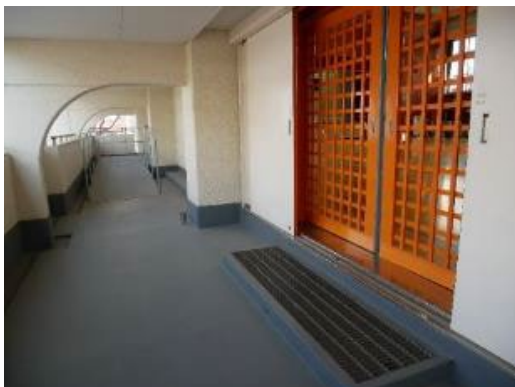
スロープの設置された屋内運動場の出入口
