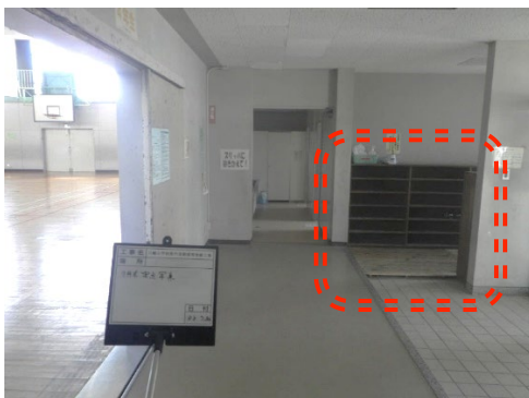
改修前(赤枠部分が下足置き場)
