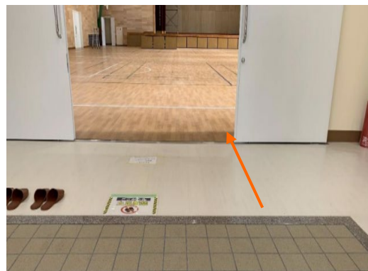
前室床もスロープになっており段差解消している
