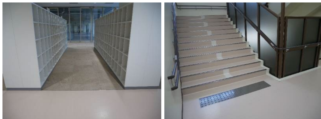
外履き部分と上履き部分で床高を併せた昇降口 点状ブロック、手すりを設けた階段
