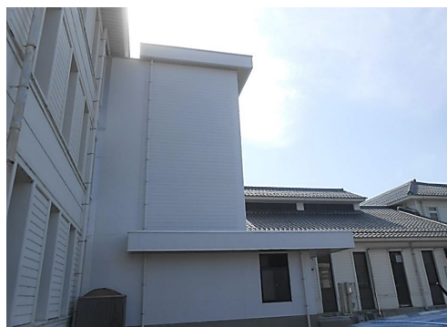
エレベーター棟設置後の外観
