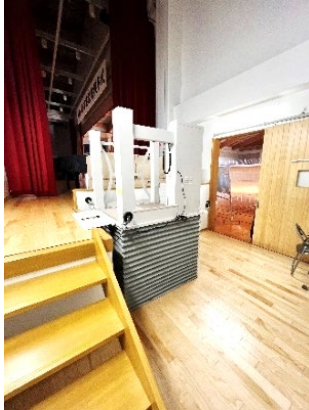
屋内運動場ステージ脇に設置された段差解消機
