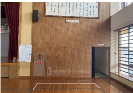
ステージ昇降用スロープの入り口(写真右下)
