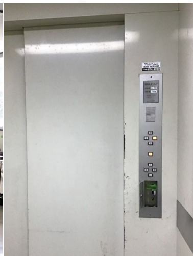
改修前の人荷共用エレベーター内部
