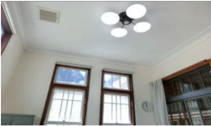
内壁や天井に改修前にも使われていた漆喰を採用 (愛媛県伊予市立翠小学校)
