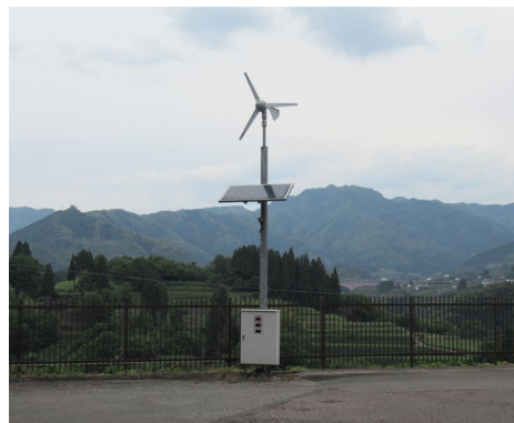
風力・太陽光発電による夜間照明 (宮崎県日之影町立日之影中学校)
