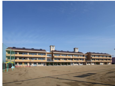
屋根の上に30kWの太陽光発電パネルを設置 (兵庫県神戸市立井吹の丘小学校)
