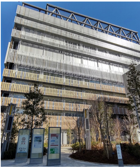
再生木を使用した日射遮断ルーバー (東京都港区立芝浜小学校)
