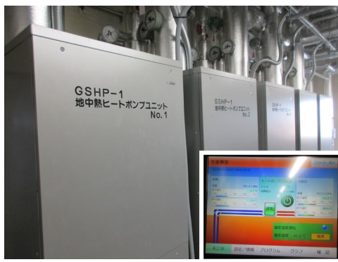
地中熱ヒートポンプユニットと 校内に設置された稼働状況を示すモニター (青森県鶴田町立鶴田小学校)
