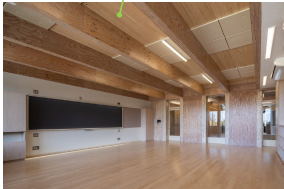
床版にCLTを利用した普通教室 (千葉県流山市立おおぐろの森中学校)
