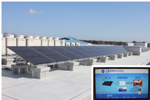
屋上に20kWの太陽光発電パネルを設置 (長崎県南島原市立有家小学校)
