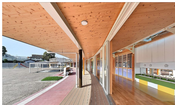
木質化された廊下とCLTを利用した天井 (香川県観音寺市立観音寺中央幼稚園)
