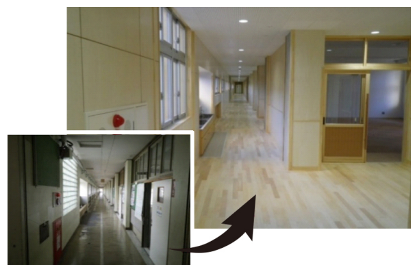
廊下の壁を一部撤去して多目的スペースを
