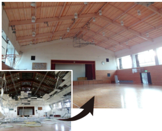
屋内運動場の吊り天井の落下防止対策の例（天井撤去）
