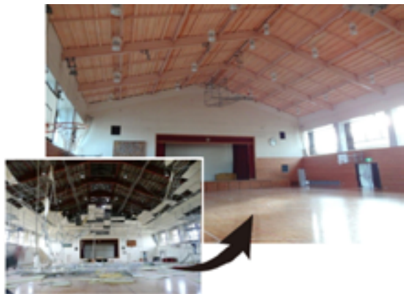
屋内運動場の吊り天井の落下防止対策の例（天井撤去）
