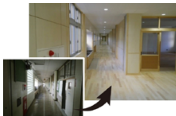
廊下の壁を一部撤去して多目的スペースを
