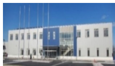
廃炉環境国際共同研究センター(CLADS)「国際共同研究棟」
