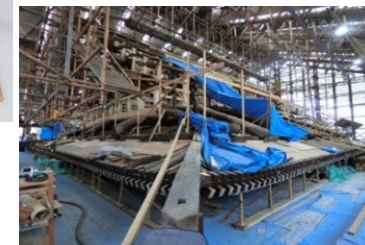
<建造物半解体修理の様子> 重要文化財 本隆寺本堂 (京都府京都市)
