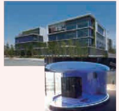
東工大 中分子 IT 創薬研究推進体 殿町拠点
