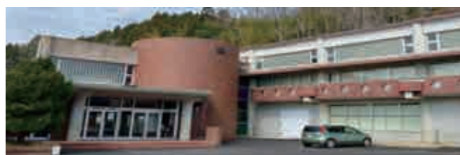
(株) I・D・F (旧飯野川第二小学校) 全景
