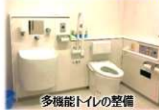
多機能トイレの整備
