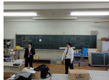
総合教室（改修前）
