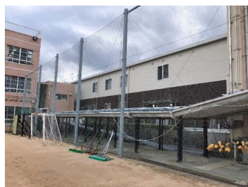
小・中学校共用のグラウンドに隣接して設置し、小・中学校の敷地から直接アクセスできる
