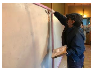
⑧漆喰塗りの様子
