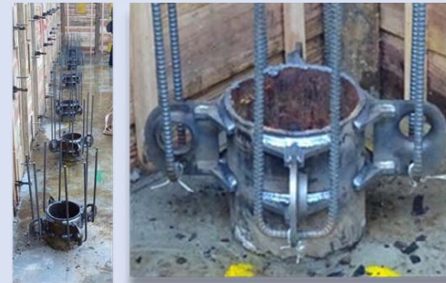
写真2 バーリング杭頭接合法「BRパイルラクウェル」(現場採用状況)
