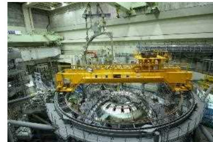
TFコイルの組立中
