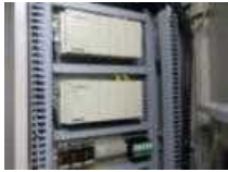
空調自動制御システムの更新
