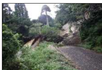
大雨による林道崩落
