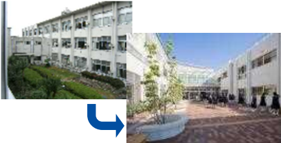
長寿命化改修による教育環境向上と老朽化対策の一体的整備
