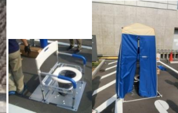
マンホールトイレ
