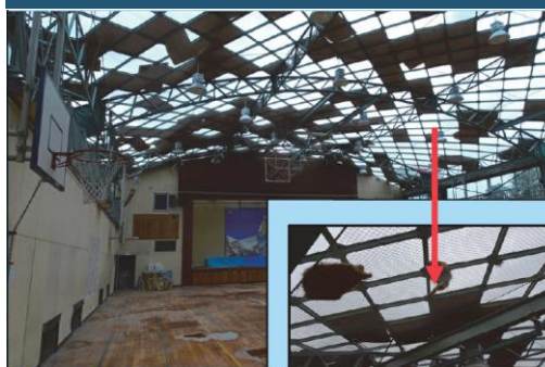
屋内運動場屋根ふき材等の飛散
