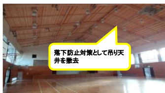
天井等落下防止対策
