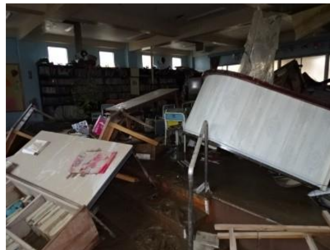
令和2年7月豪雨 図書室への床上浸水
