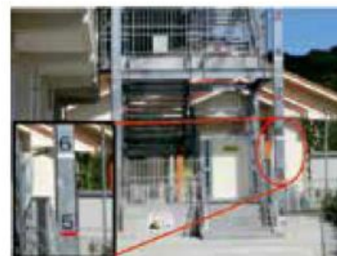
屋外避難階段の柱に 設けた標高表示
