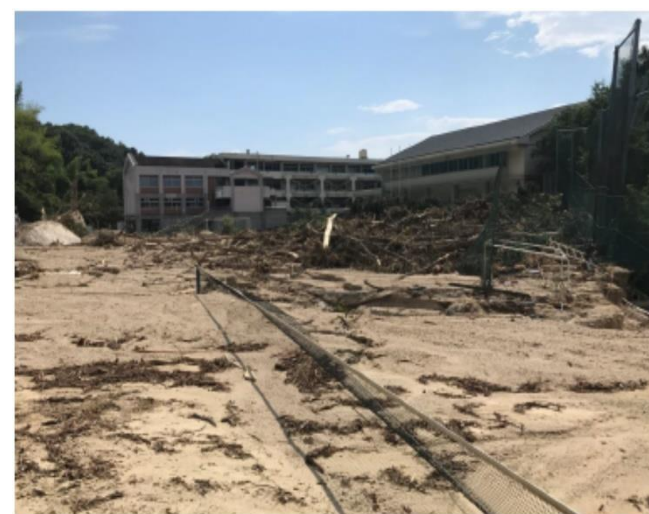
平成30年7月豪雨 建物への土砂流入
