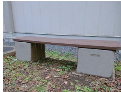
(防災トイレ兼ベンチ)
