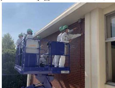
非破壊試験（打診検査）
