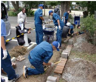
近隣福祉施設への花壇施工
