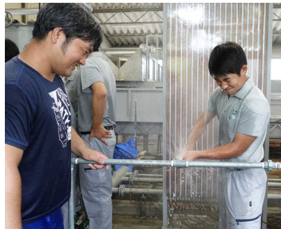
管工事補修実習
