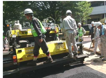
アスファルト 舗装実習
