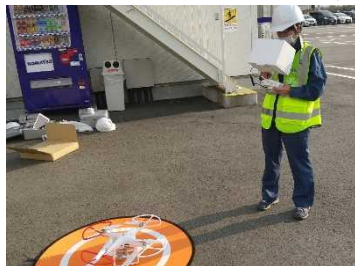
ドローンによる UAV 測量
