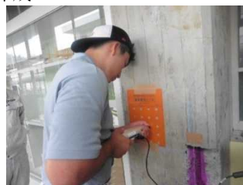
非破壊試験（中性化検査）
