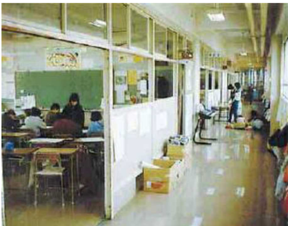
廊下と壁がある普通教室（改修前）
