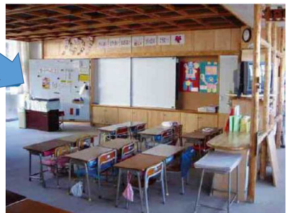
廊下との間仕切りを撤去（改修後）
