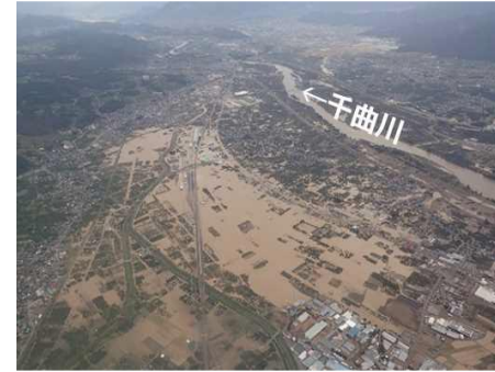
令和元年度台風19号による千曲川における浸水被害状況(長野県長野市)
