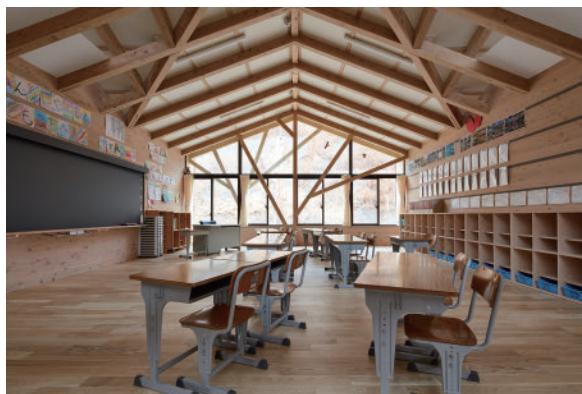
改築が完了した校舎
