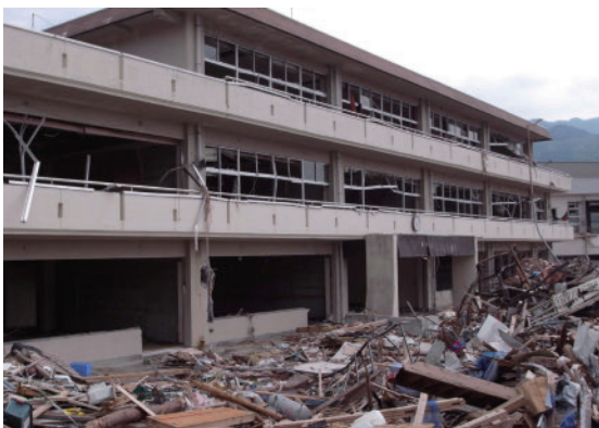
津波により被害を受けた校舎
