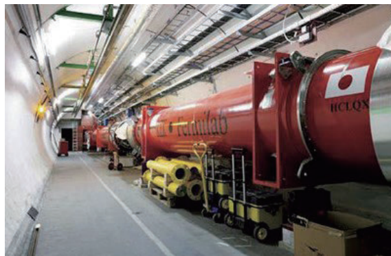
大型ハドロン衝突型加速器 (LHC) の一部
