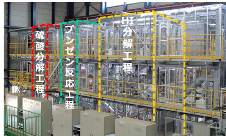
ISプロセス連続水素製造試験装置
