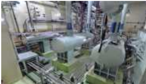
解体手順の確認・検討
