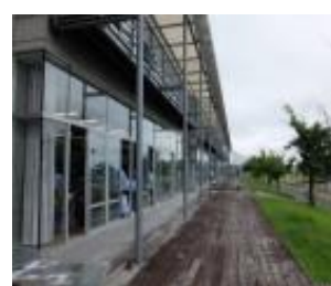
▲ウッドデッキテラス
