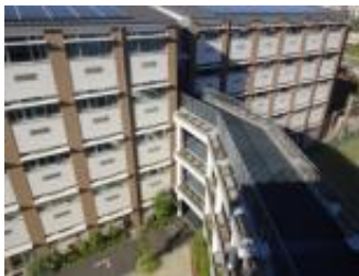
▲教室棟とアリーナ棟には避難やバリアフリーに配慮し渡り廊下を複数階に設置。
