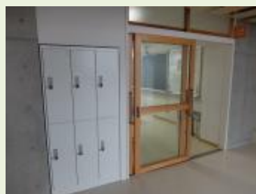
廊下の壁と一体で整備された生徒用ロッカー
