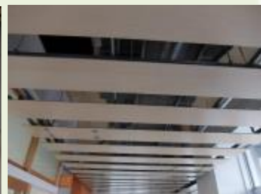
メンテナンスを考慮した廊下の天井
