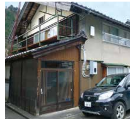
北陸サテライトは築百年の古民家を改修。1階は32畳分のフロアリングだ
