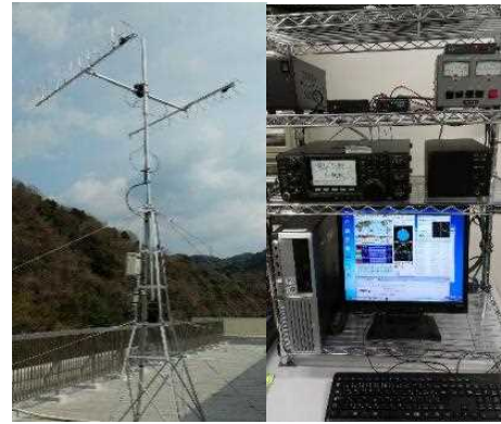
拠点地上局の外観
