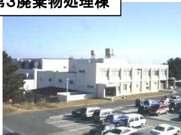
第3廃棄物処理棟
