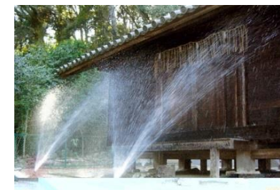
《消火施設(放水銃)の設置》
