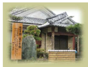
迎賓館第1号館
