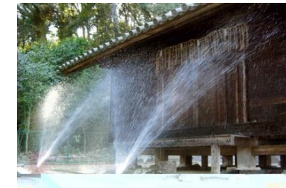
《消火施設(放水銃)の設置》
