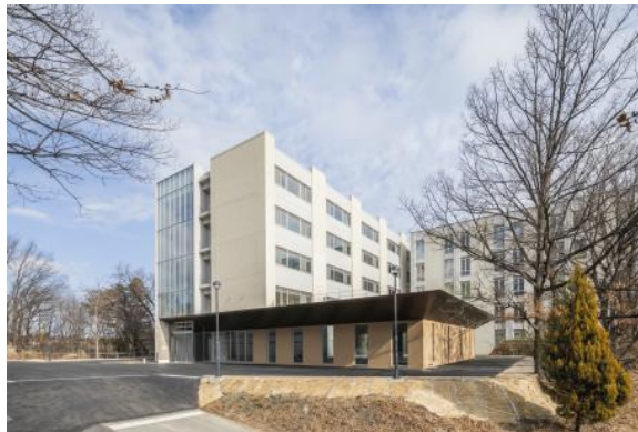
食農学類研究棟外観南東面
