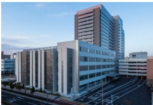
図表18 東北大学 先進医療棟 (最先端の医療設備を備えた診療棟の整備)
