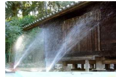
《消火施設(放水銃)の設置》
