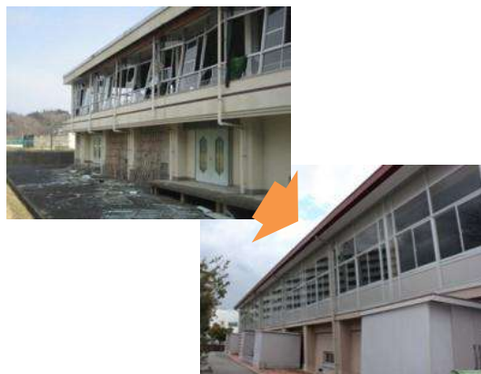
非構造部材の耐震対策
