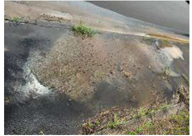
地中埋設配管からの漏水実例 (令和2年10月30日)
