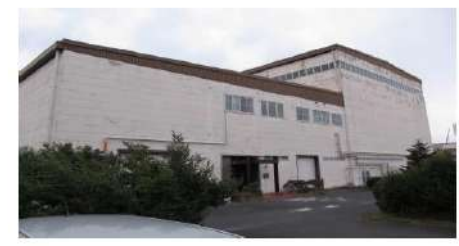
那珂地区 第1工学試験棟 (昭和55年度竣工)
