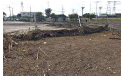
《グラウンドへの土砂流入によるフェンス破損》
