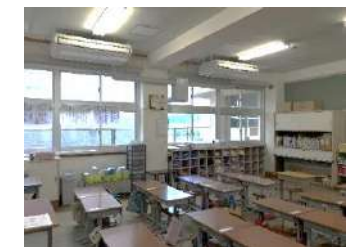
空調設備・換気設備を備えた教室
