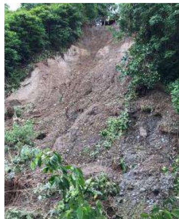
史跡 人吉城跡 (熊本県人吉市) 令和2年7月豪雨による土砂崩れ
