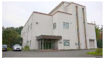
高崎研 1号加速器棟 (昭和55年度竣工)
