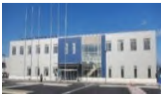
廃炉環境国際共同研究センター(CLADS)「国際共同研究棟」
