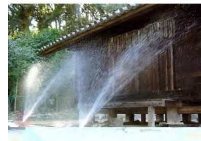
≪ 消火施設(放水銃)の設置 ≫
