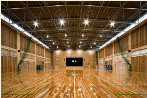
栃木県茂木町立茂木中学校（トラス架構）
