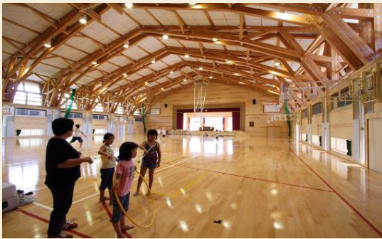
秋田県能代市立浅内小学校（トラス架構）
