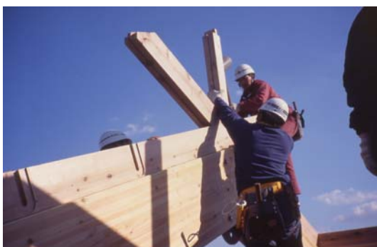
体育館 全自動プレカット加工された垂木
