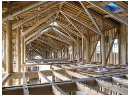
2階部分の建て方風景
