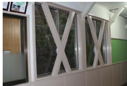
筋交いによる壁補強（追分小学校）
