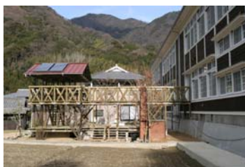
エコデッキ外観、手前にレンガ造りの既存焼却炉
