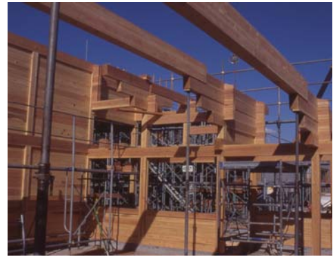
教室棟 持送り重ね梁と落込み板壁
