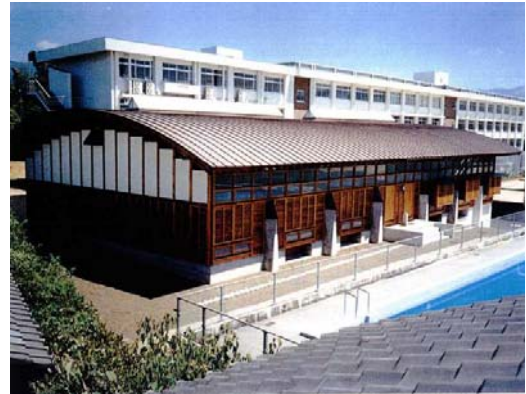
外観（方杖を支持しているRC造の片持ち柱が見える）
