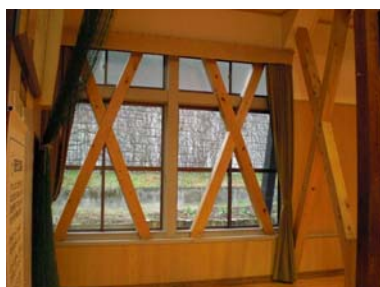
筋交いによる壁補強（足助小学校）
