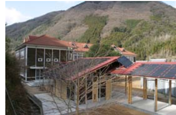
屋根材一体型太陽発電パネルの屋根と小型風力発電機
