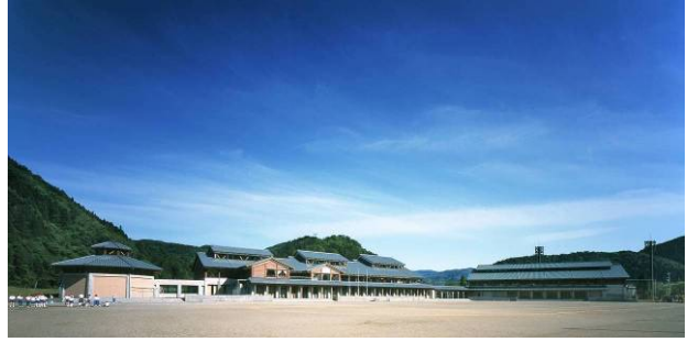
グラウンド側外観
