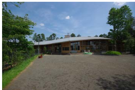
1階2階部分を1つの屋根で覆うため屋根面が起伏している
