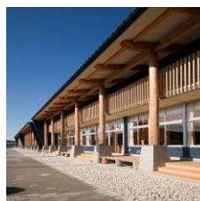
普通教室棟南面の軒先
