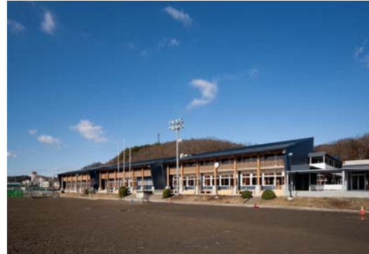
茂木中学校校舎全景 (南面)
