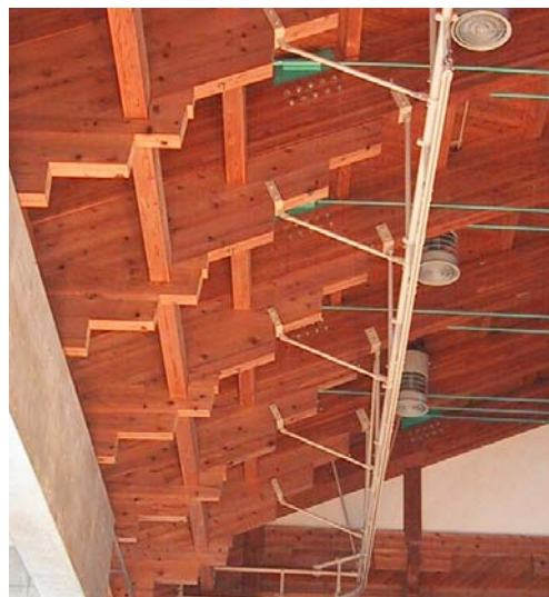
体育館の持ち送り重ね梁部分
