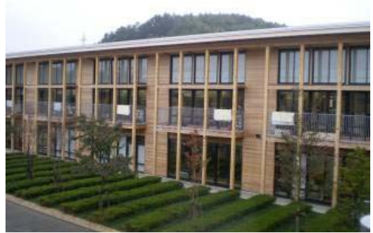
学習棟南側外観
