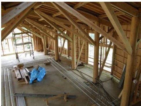
1階部分の建て方風景
