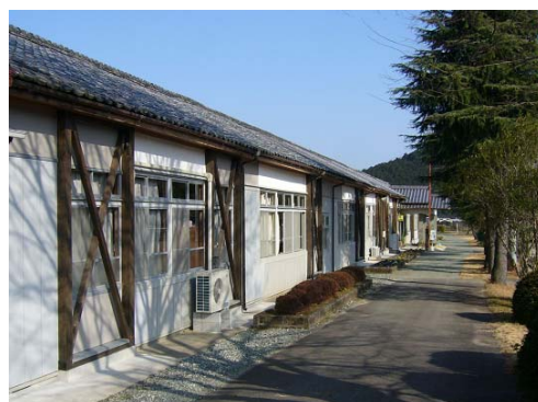
南棟西側外観
