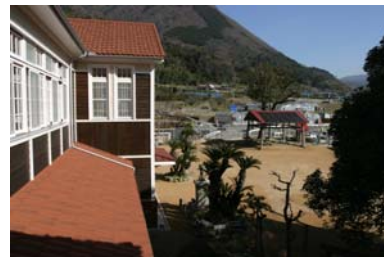
昭和の改修でアルミサッシになっていたものを、機密性の高い木製サッシに改修
