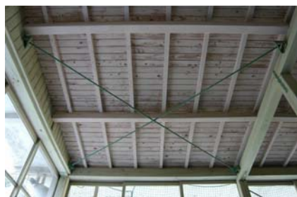
ブレースによる屋根補強
