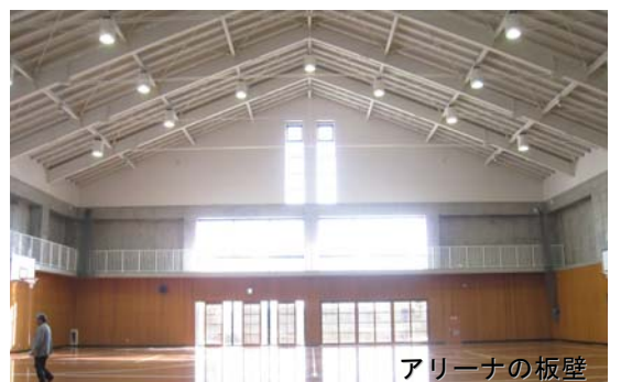
3階普通教室の板張り天井
