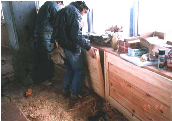
ハーフパネルの施工
