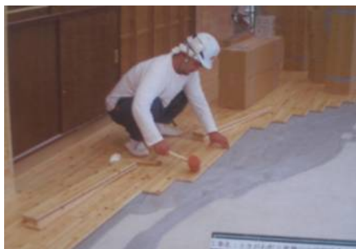
工期短縮のため、モルタル仕上げ面にラバー付きの床材を直接施工（都幾川中学校）
