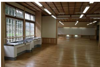
内部のスギ板の腰板とスギ板竿縁天井
