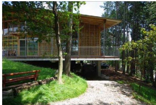
鉄筋コンクリート造の基礎部分
