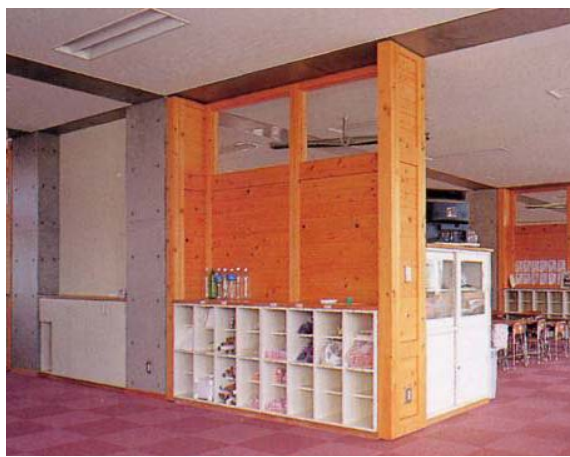
教室間とオープンスペースにしつらえられた木製インフィル
