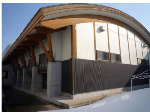
外観（RC造の片持ち柱が見える）
