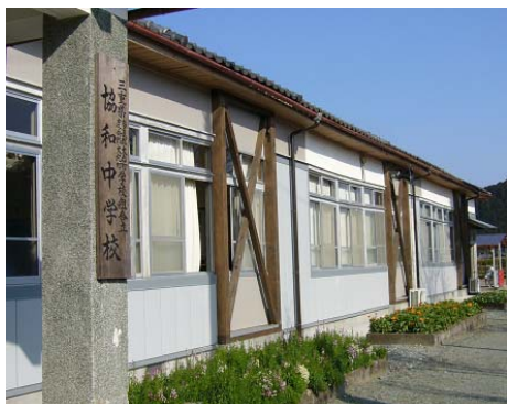
南棟東側外観
