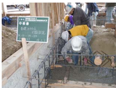
鉄筋コンクリート造の基礎の併設
