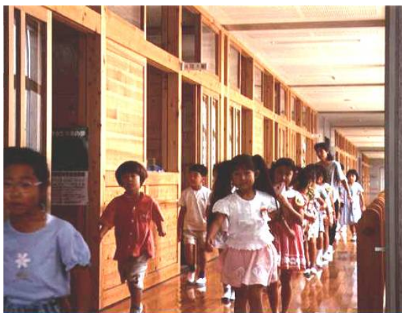
教室と廊下を仕切る木製インフィル
