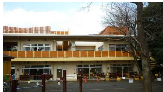
間伐材を使用したバルコニー手すり
