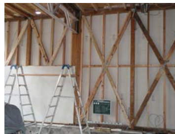
耐力壁補強の施工状況
