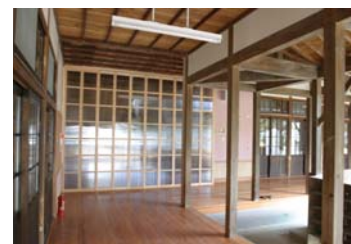
開放廊下の冬季対策としての開放階段室前の可動間仕切
