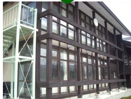
土淵中学校 校舎外観 (上) 塗装前、(下) 塗装後
