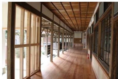
職員室からグランドへの視認性をよくするためのポリカーボネード製の耐震壁
