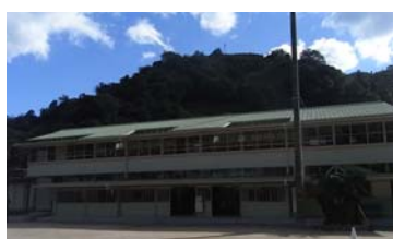
日土小学校 既存校舎棟
