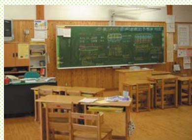
福井県越前市立白山小学校・床、壁の木質化
