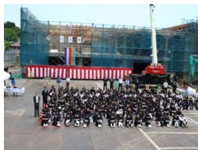
生徒全員参加による上棟式
