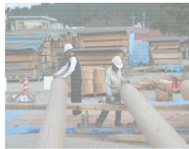
地元大工による丸太材の加工
