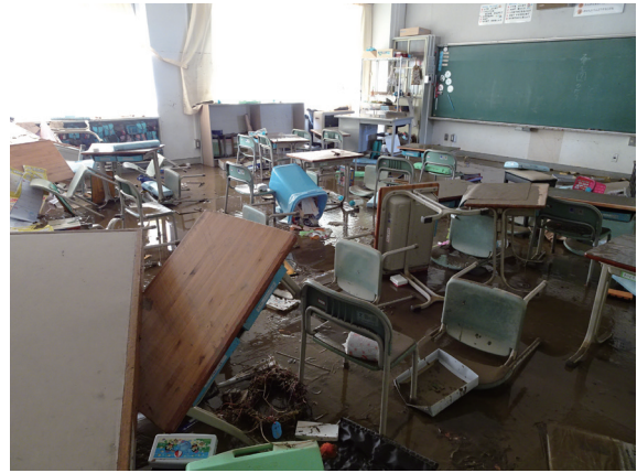
令和元年東日本台風(台風第19号)で生じた教室への浸水
