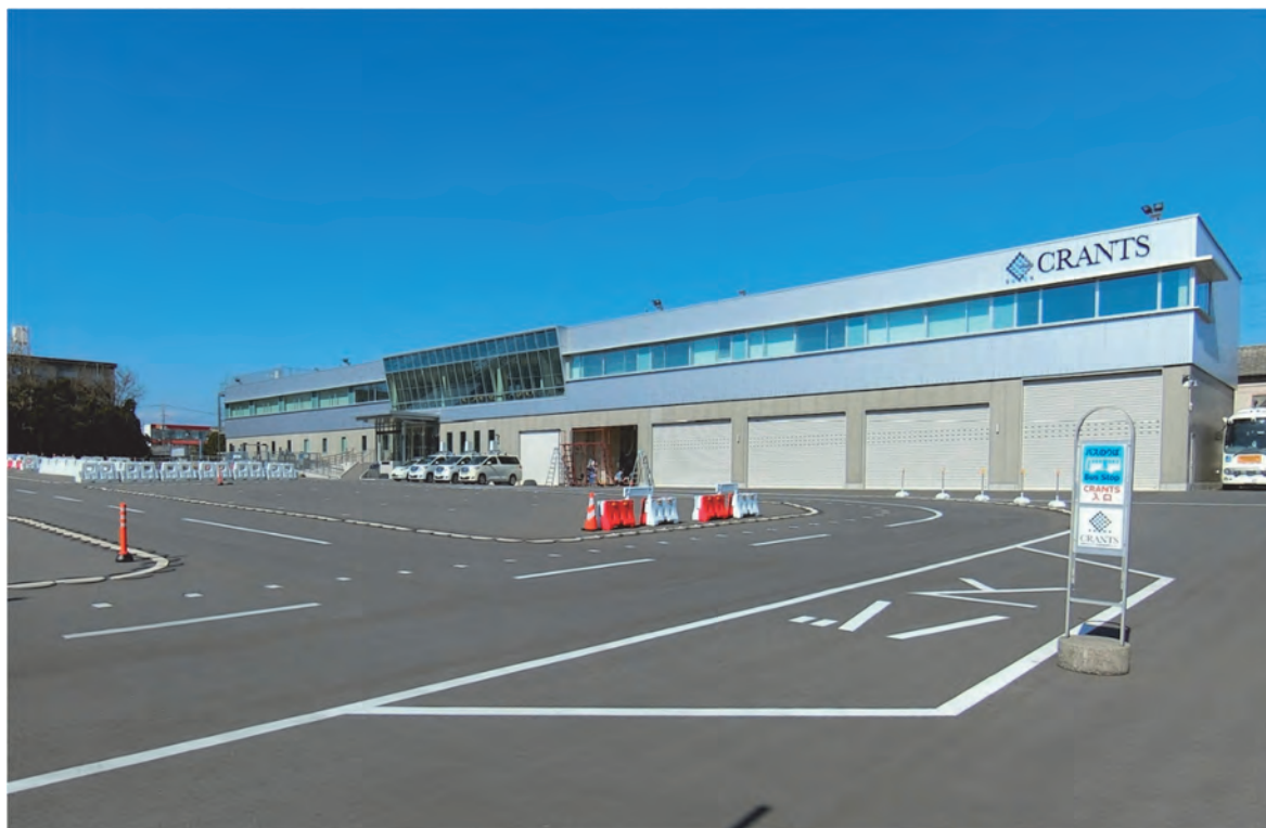
総合研究棟と専用試験路
