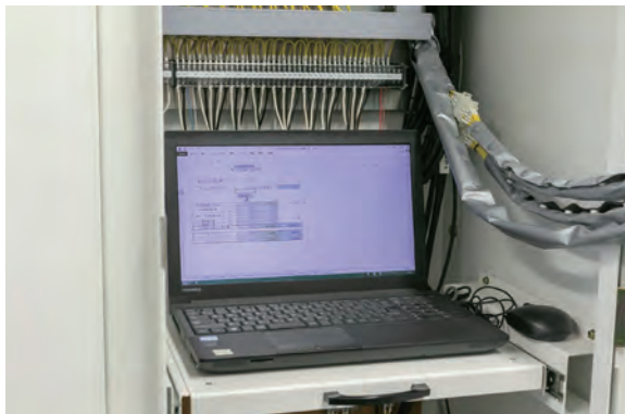
工場用BEMS (ビルエネルギーマネジメントシステム)
