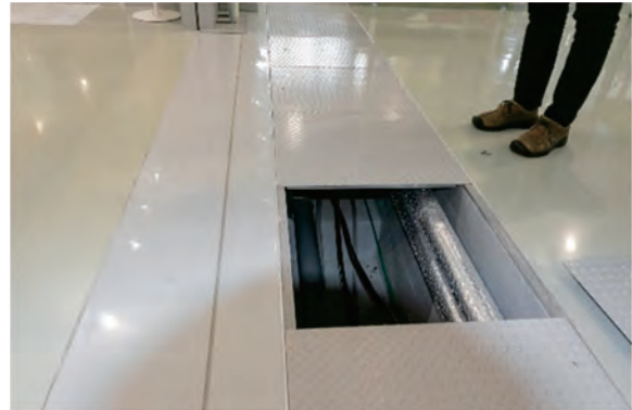
大型実験室の床下ピット
