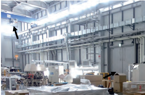
大型設備スペースの開口及びクレーン設備
