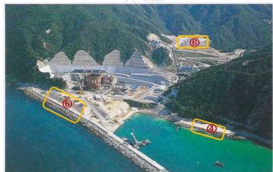
(c) C矢視(もんじゅ建設工事時)
