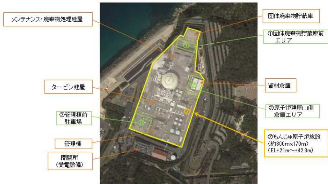
図 8-7 ①、②、③及び⑦もんじゅ施設設置場所
