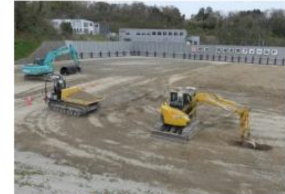
遠隔施工システム 鹿島建設(株)
