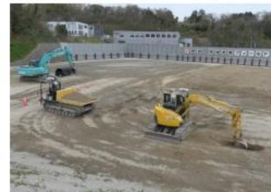
遠隔施工システム 鹿島建設(株)
