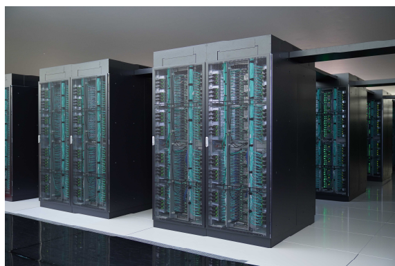
スーパーコンピュータ「富岳」(※搬入・設置中 提供：理化学研究所)
