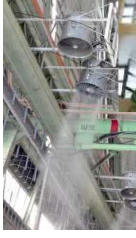
(整備の一例) 換気扇の設置
