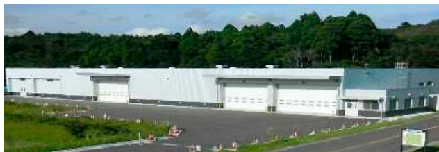
防災拠点備蓄基地
