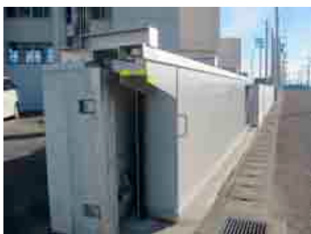
学校敷地を囲う多目的擁壁
