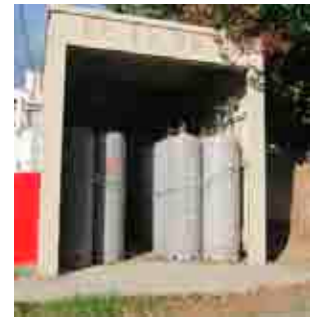
プロパンガスの保管状況
