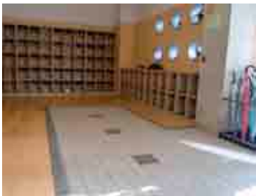
段差を無くした入口部分
