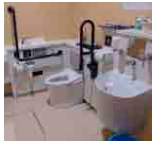
多目的トイレの設置
