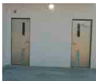
外部から使用できるトイレ
