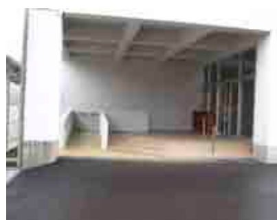
スロープが設置された体育館入口
