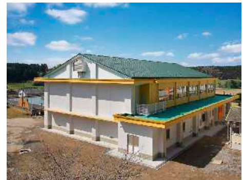
櫛小学校の体育館
