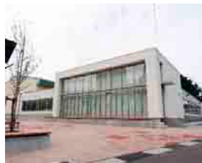
関根中学校の多目的ホール
