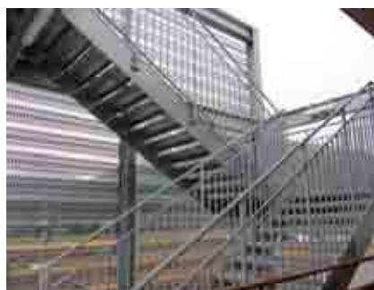
外階段の設置
