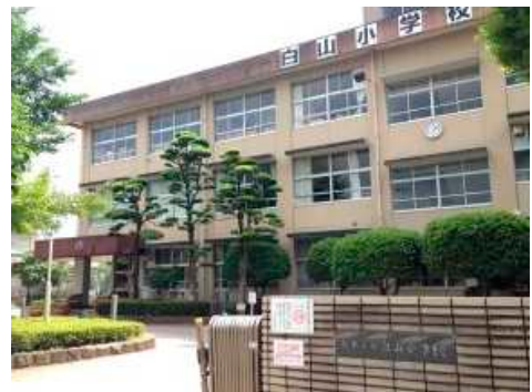
白山小学校の校舎
