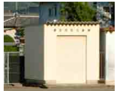
校庭側に設置された備蓄倉庫
