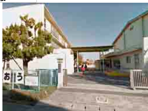
橋北小学校の体育館入り口部
