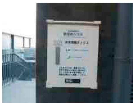
建物の2階以上に避難するための鍵ボックス
