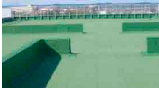
屋上部の避難スペース
