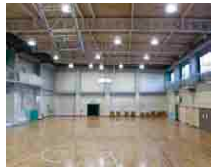
体育館のLED照明
