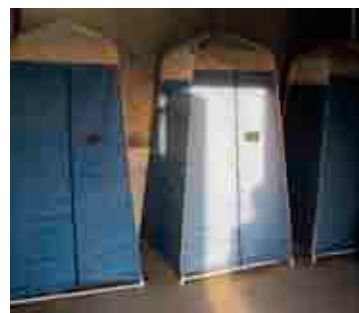
屋内設置のマンホールトイレ
