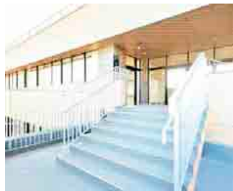
外階段から多目的ホールへのアクセス通路
