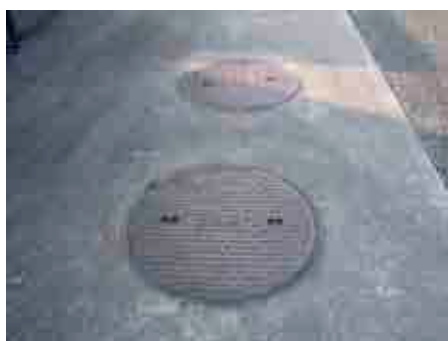
受水槽地下の雨水タンク
