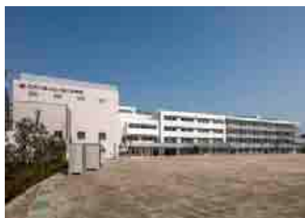
小松川第二中学校の校舎
