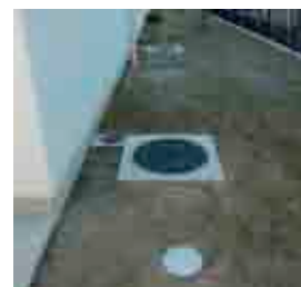
マンホールトイレ
