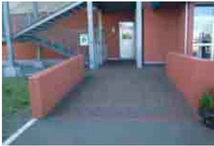
外階段へのスロープ設置
