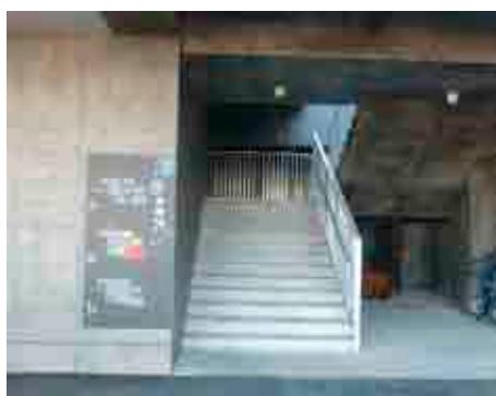
屋上に避難するための入り口部分と階段
