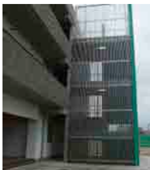
外階段の設置
