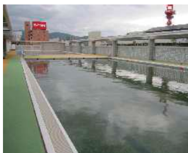
屋上に設置された小中2校のプール
