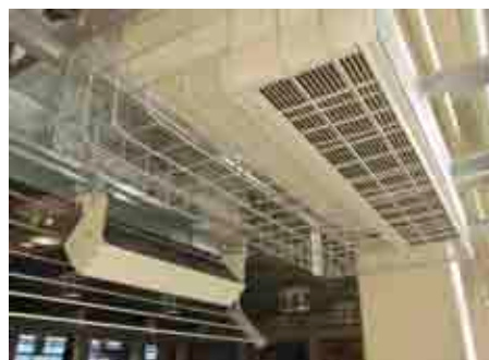
体育館のエアコン設置
