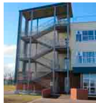
外階段の増築
